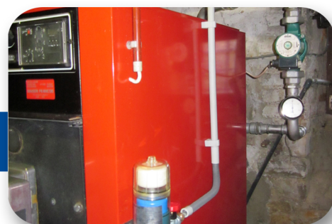
Raccordement et mise à feu de la chaudière
