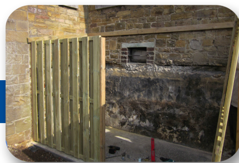
Montage de la charpente et des palissades en bois
