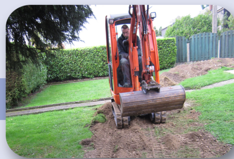
Remblayage avec la bonne terre stocké
