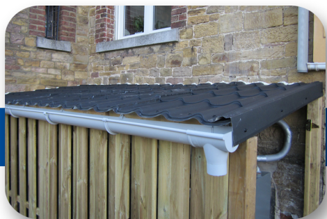
Montage de la toiture, de la gouttière et des descentes d'eau
