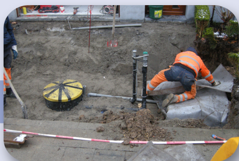
Montage d'un drain de dispersion pour évacuer les eaux de la CV
