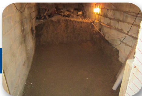
Nivellement du sol
