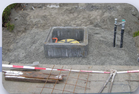
Réalisation d'une dalle de béton armé de 15 cm permettant la circulation d'engins lourds
