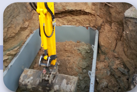
Sécurisation et blindage de la fouille
