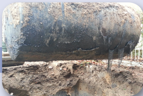
Excavation de l'ancien réservoir
