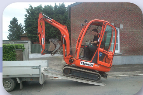
Mise en place des machines et du matériel
