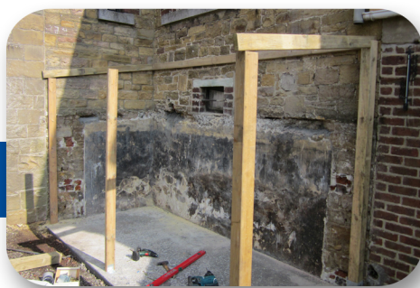
Fixation des piquets avec des sabots en acier galvanisé
