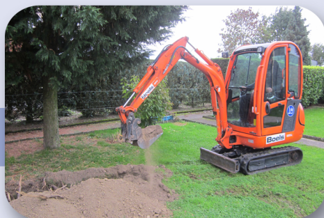
Réalisation d'une tranchée hors gel (60 cm de profondeur)
