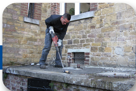
Démolition de l'ancienne toiture
