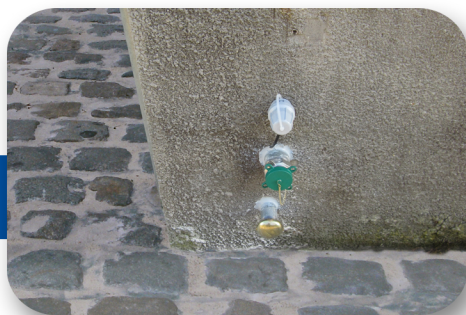
Placement de la sonde anti-débordement
