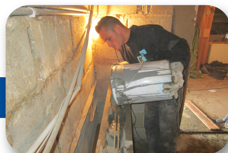
Coulage au sceau du béton
