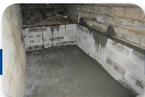
Nettoyage et reprise du matériel
