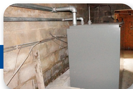
Montage des tuyaux de remplissage et ventilation
