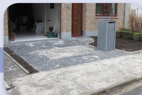
Remise en état des lieux, klinkers, trottoir, bordure
