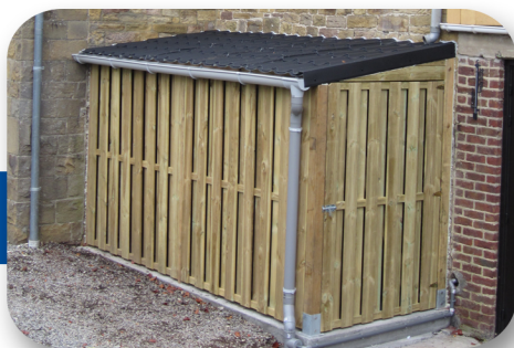
Montage porte, quincaillerie et finitions diverses
