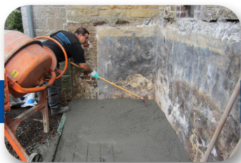
Réalisation d'une dalle de béton armé de 15 cm
