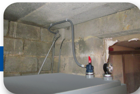
Montage aspiration mazout et jauge mécanique
