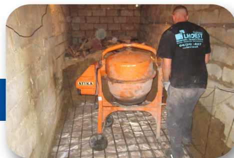
Montage du ferrailage de la dalle et de la base du mur
