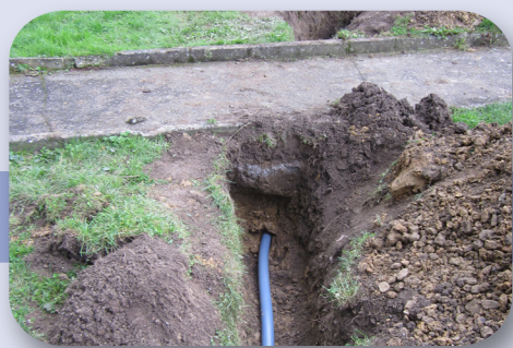
Placement du gainage et des tuyauteries d'alimentation
