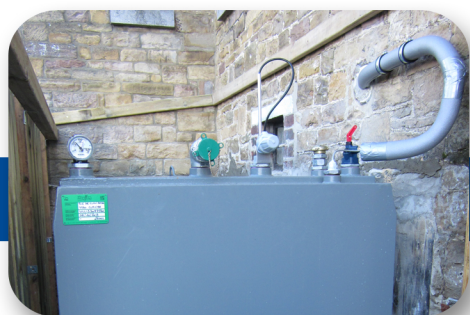
Livraison du nouveau réservoir et montage des accessoires
