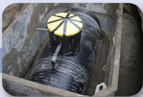
Mise en place du nouveau réservoir et remblayage au stabilisé
