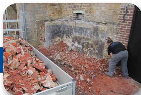
Démolition de l'ancien abri et évacuation des gravas
