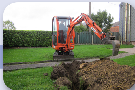
Terrassement et fonçage sous les trottoirs
