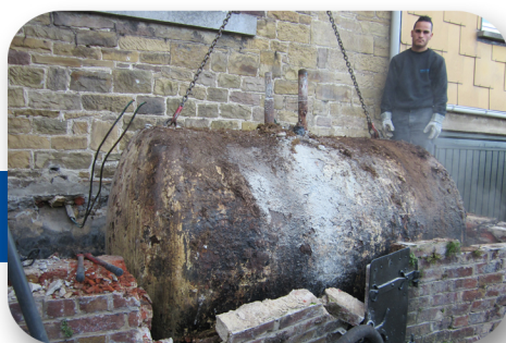
Nettoyage et évacuation du vieux réservoir
