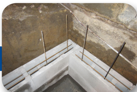
Montage étage par étage du mur en bloc stépoc et du ferrailage le renforçant
