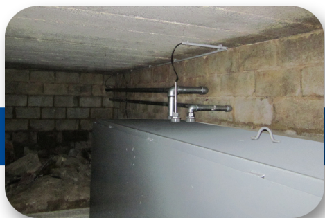
Carrotage mur extérieur
