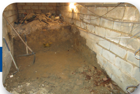
Terrassement et évacuation des terres
