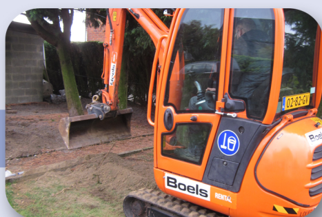
Damage et nivellement de la surface
